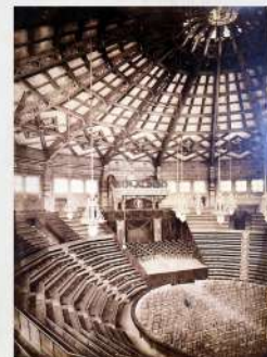
Aperçu de la structure métallique / Source: Archives départementales de la Somme
